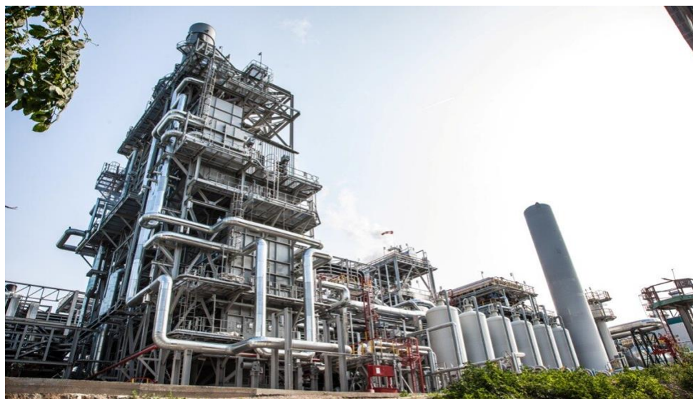
Рис. 3.10.2. Производство водорода методом риформинга (конверсии) метана
