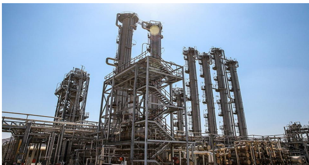
Рис. 3.10.5. Завод по производству тяжелой воды в Канаде для реакторов типа CANDU
